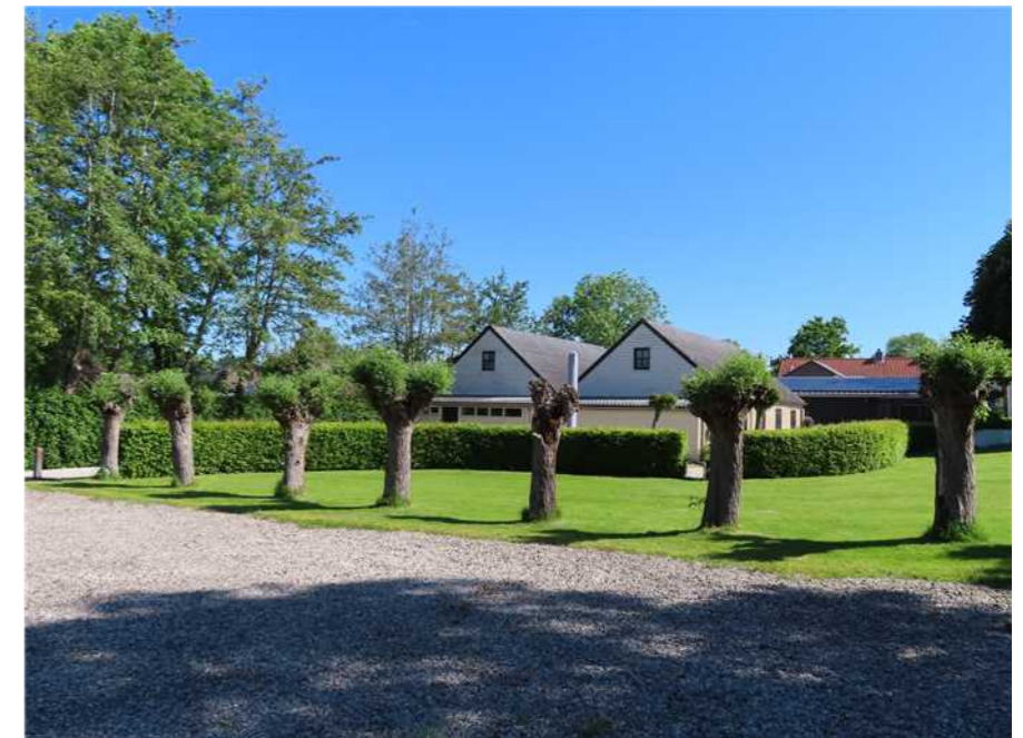
Foto's bestaande situatie
